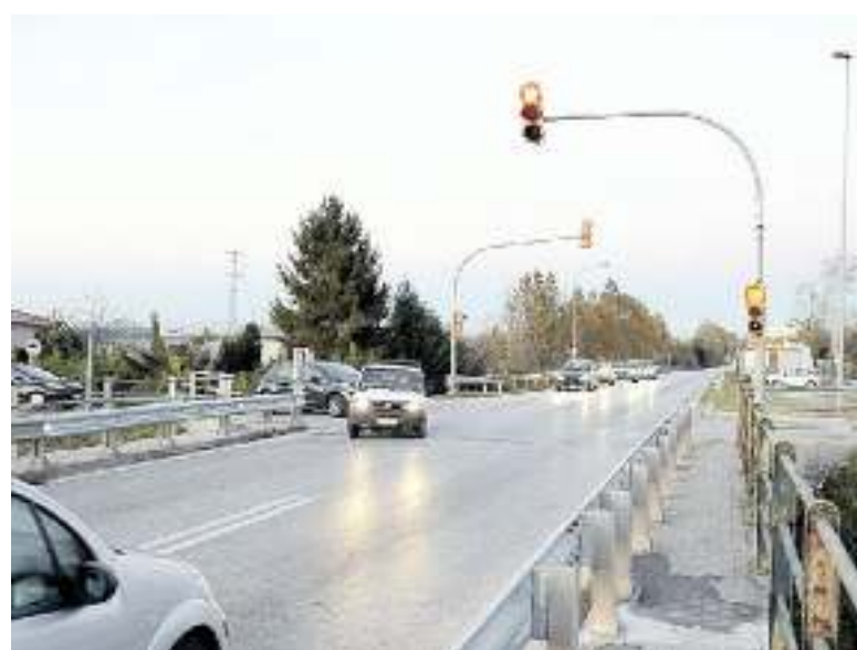
PONTE "DELLA PROVINCIA" Gli impianti attualmente esistenti saranno praticamente raddoppiati.
