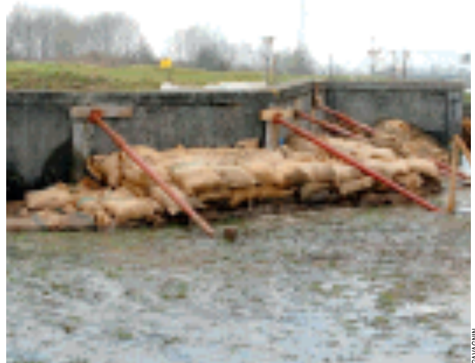
L'argine del fiume Loncon ad Annone puntellato dalla protezione civile
