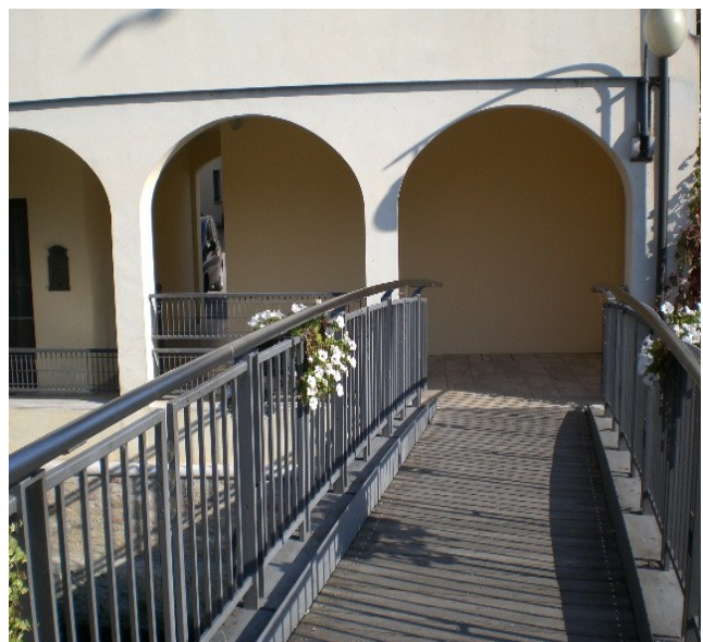
parete abitazione riportata come era in origine
