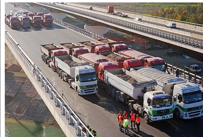
Una fase delle prove di carico del nuovo ponte sul Piave
