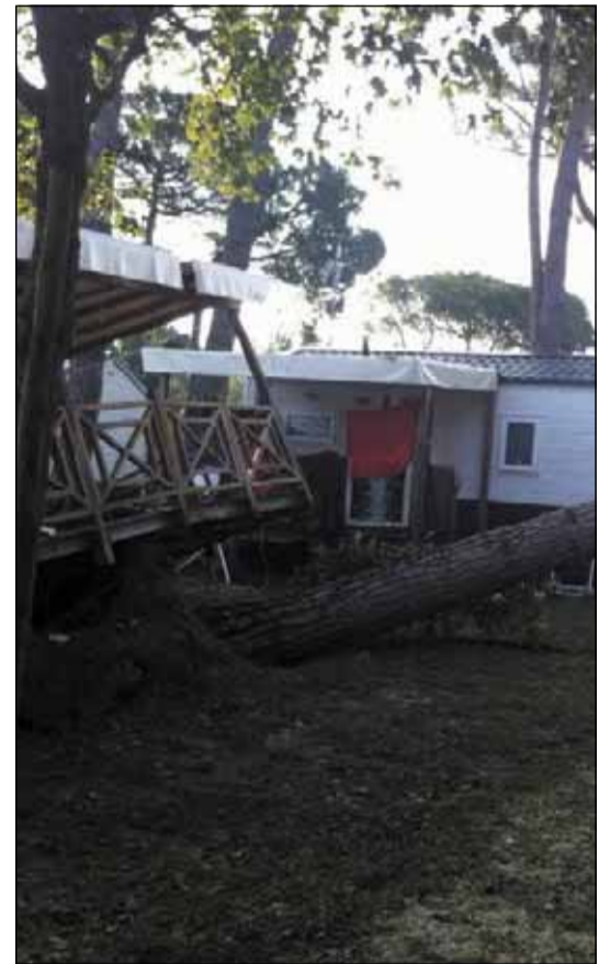
DANNEGGIATE Le casette prefabbricate del campeggio
