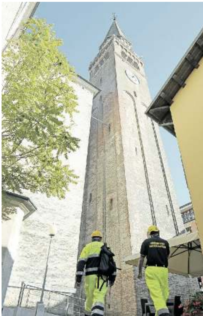
PORTOGRUARO Arrivano i soldi dal ministero per il campanile
