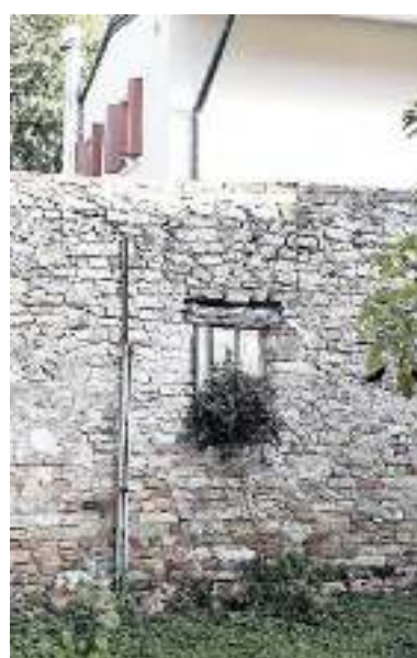
RISALE AL '700 Il muro di cinta in zona vincolata
