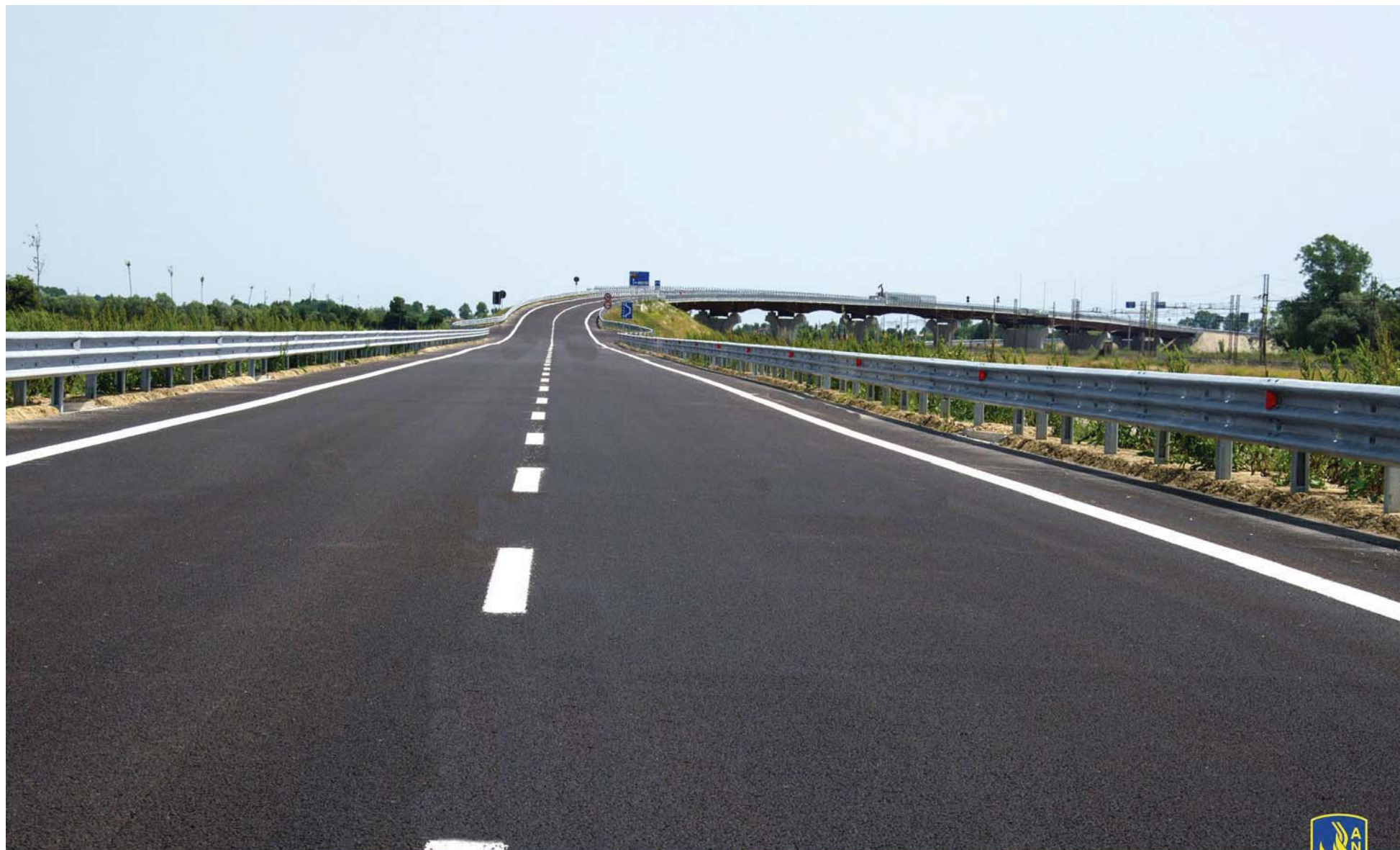
Strada statale 14 “della Venezia Giulia” – IV lotto della variante di Portogruaro, vista della variante con viadotto “Palazzetto”
