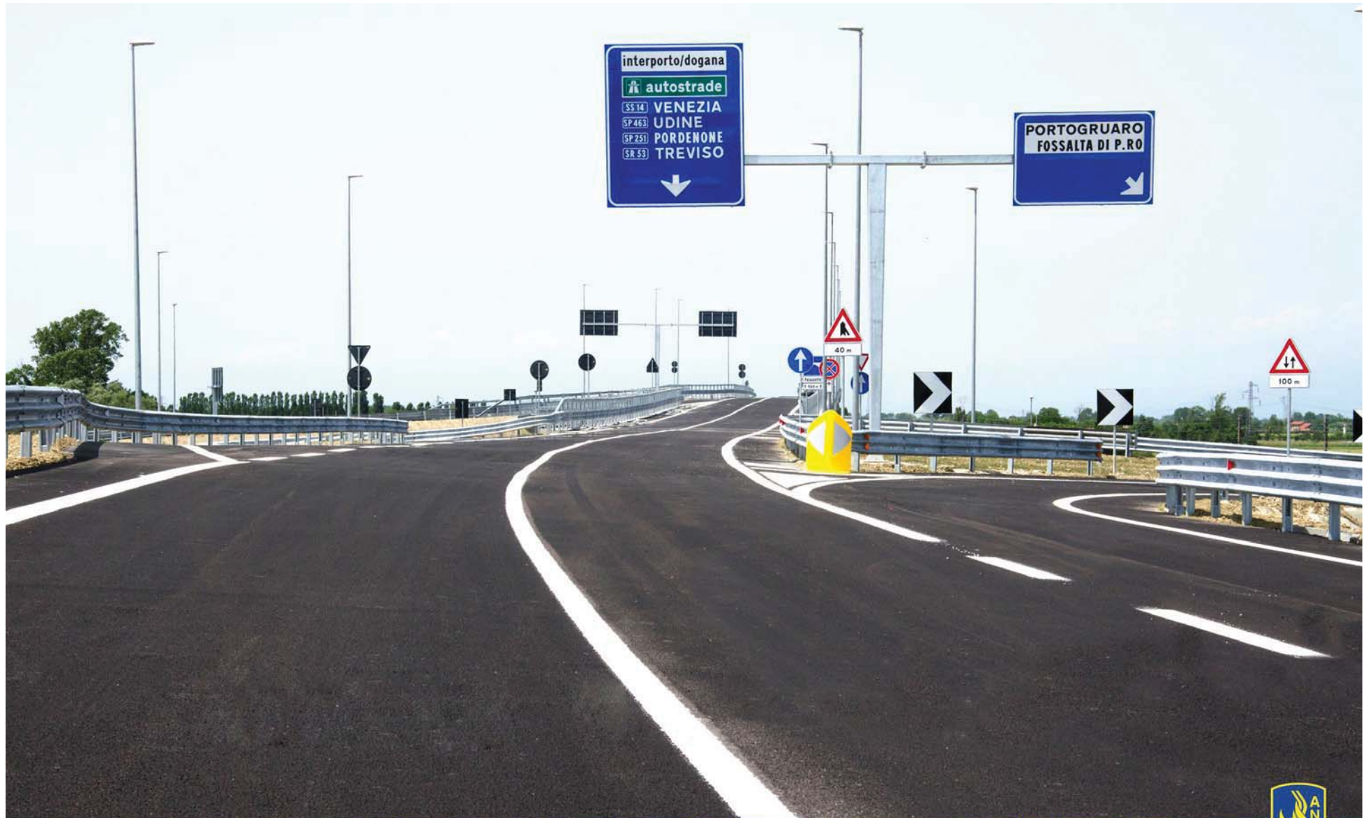
Strada statale 14 "della Venezia Giulia" - IV lotto della variante di Portogruaro, ingresso variante direzione Venezia dallo svincolo sulla strada provinciale 92
