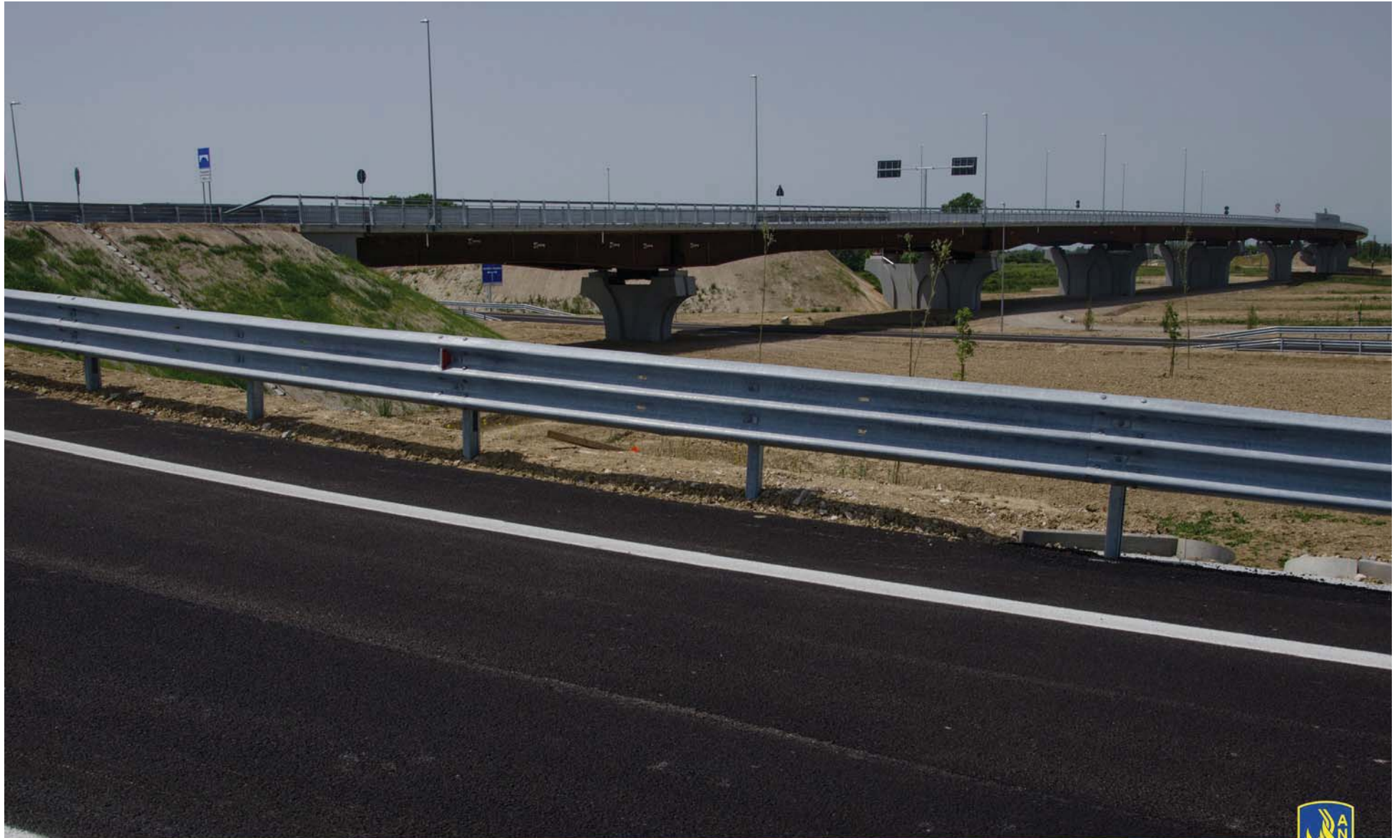
Strada statale 14 "della Venezia Giulia" - IV lotto della variante di Portogruaro, viadotto "Palazzetto" dallo svincolo sulla strada provinciale 92
