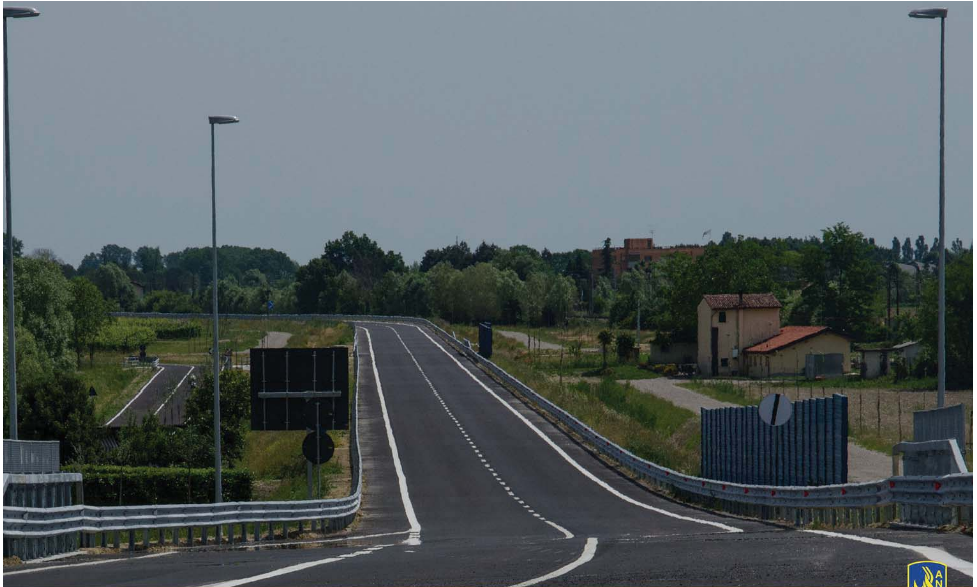
Strada statale 14 “della Venezia Giulia” – IV lotto della variante di Portogruaro, vista della variante dal cavalcavia
