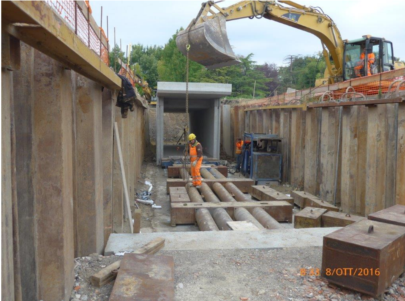
Fossalta di Portogruaro - Lavori al Sottopasso ciclopedonale sulla SS14 tra Via Nobel e Via Pascoli
