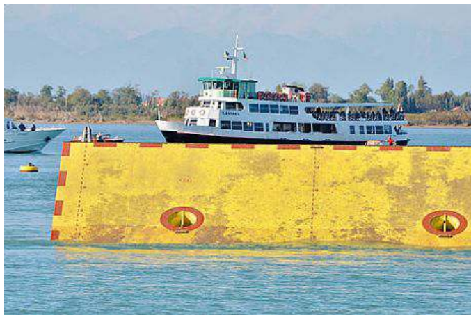
Una paratoia del Mose, il sistema che dovrà difendere Venezia
