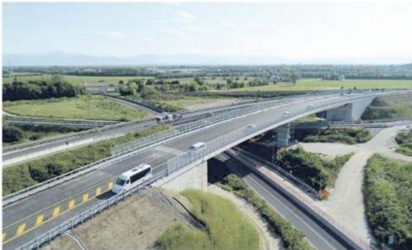
CANTIERI BLOCCATI Il tratto dell'A4 ancora privo della terza corsia è quello che collega San Donà di Piave a Portogruaro
