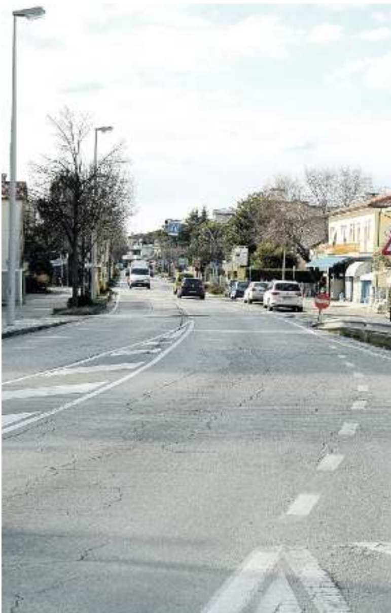
VIALE ISONZO Un tratto della strada: nei prossimi mesi nuova segnalazione e illuminazione degli attraversamenti pedonali
