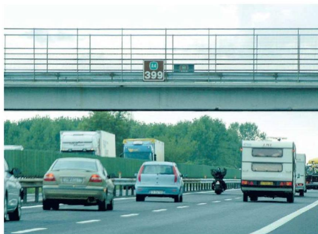
LAVORI TERZA CORSIA Il cavalcavia di Lison verrà demolito. Sopra, il sindaco Luigi Toffolo
