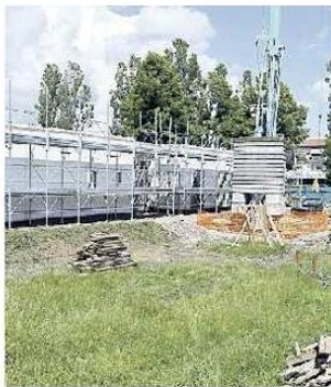
ASILO II cantiere in via Bertolini
