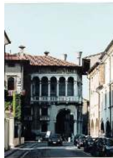
VILLA COMUNALE Storica dimora con la Sala del Caminetto
