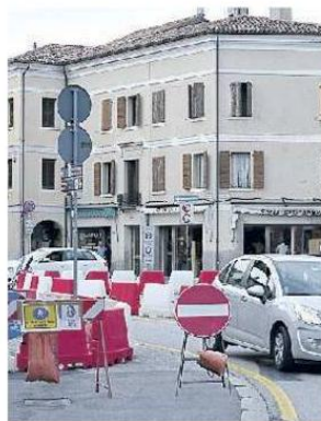
VIA MANIN Lavori in corso
