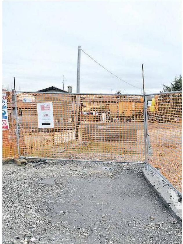
SOTTOPASSO L'opera servirà le frazioni di Pradipozzo e Summaga
