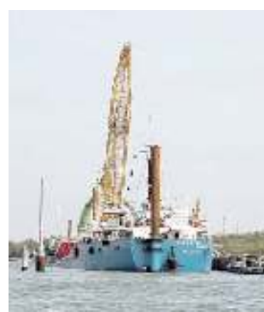
STALLO Lo scavo dei fanghi all'isola delle Tresse
