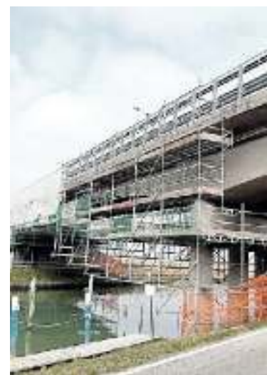
PONTE NEGRELLI Un momento dei lavori
