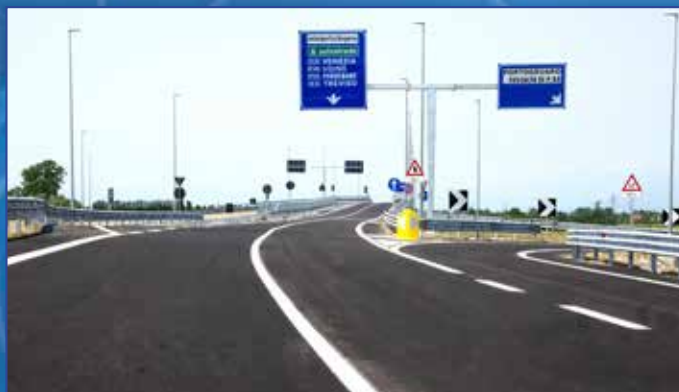
IV lotto della variante di Portogruaro, ingresso variante direzione Venezia dallo svincolo sulla strada provinciale 92
