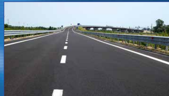
IV lotto della variante di Portogruaro, vista della variante con viadotto "Palazzetto"
