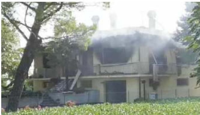
Le condizioni della villa dopo l'esplosione dovuta a una fuga di gas
