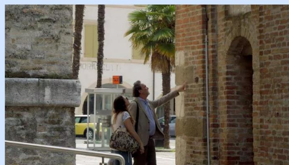
Un precedente sopralluogo al campanile di Portogruaro
