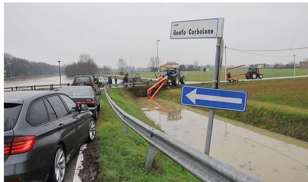
Le idrovore al lavoro ieri pomeriggio a Corbolone per vuotare i canali vicino alla campagna (foto Gavagnin)
