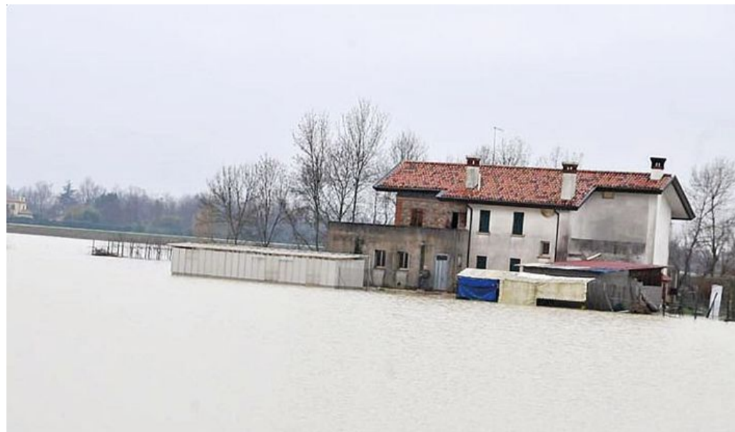
L'esondazione del Loncon ha allagato diverse abitazioni di campagna che sono state evacuate
