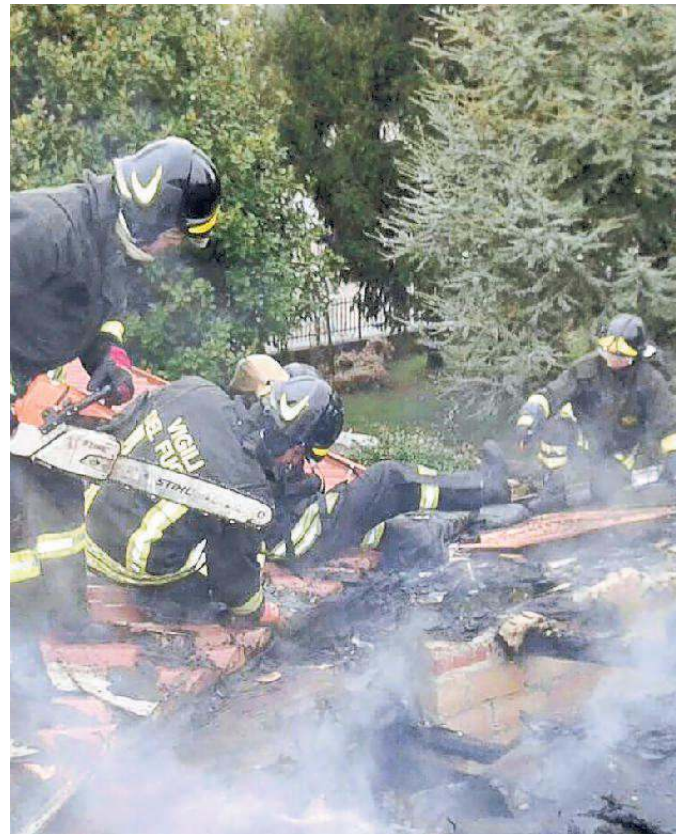
Le operazioni di messa in sicurezza della copertura (foto vigili del fuoco)
