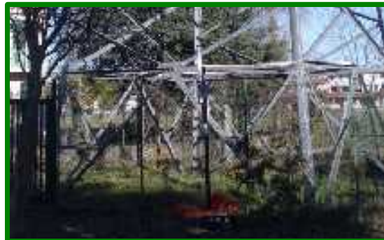
Monitoraggio traliccio scuola via Magellano
