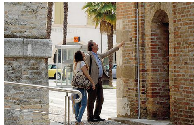
Controlli sulla staticità della torre campanaria del duomo
