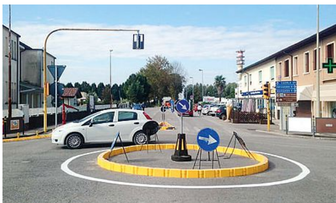
La nuova rotatoria di Lugugnana i cui lavori termineranno a breve
