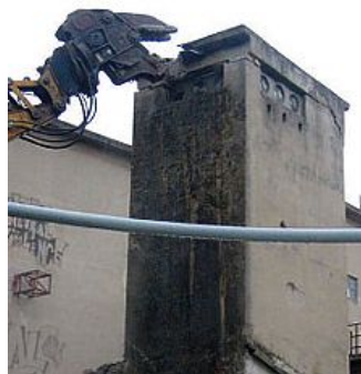
La demolizione del vecchio teatro
