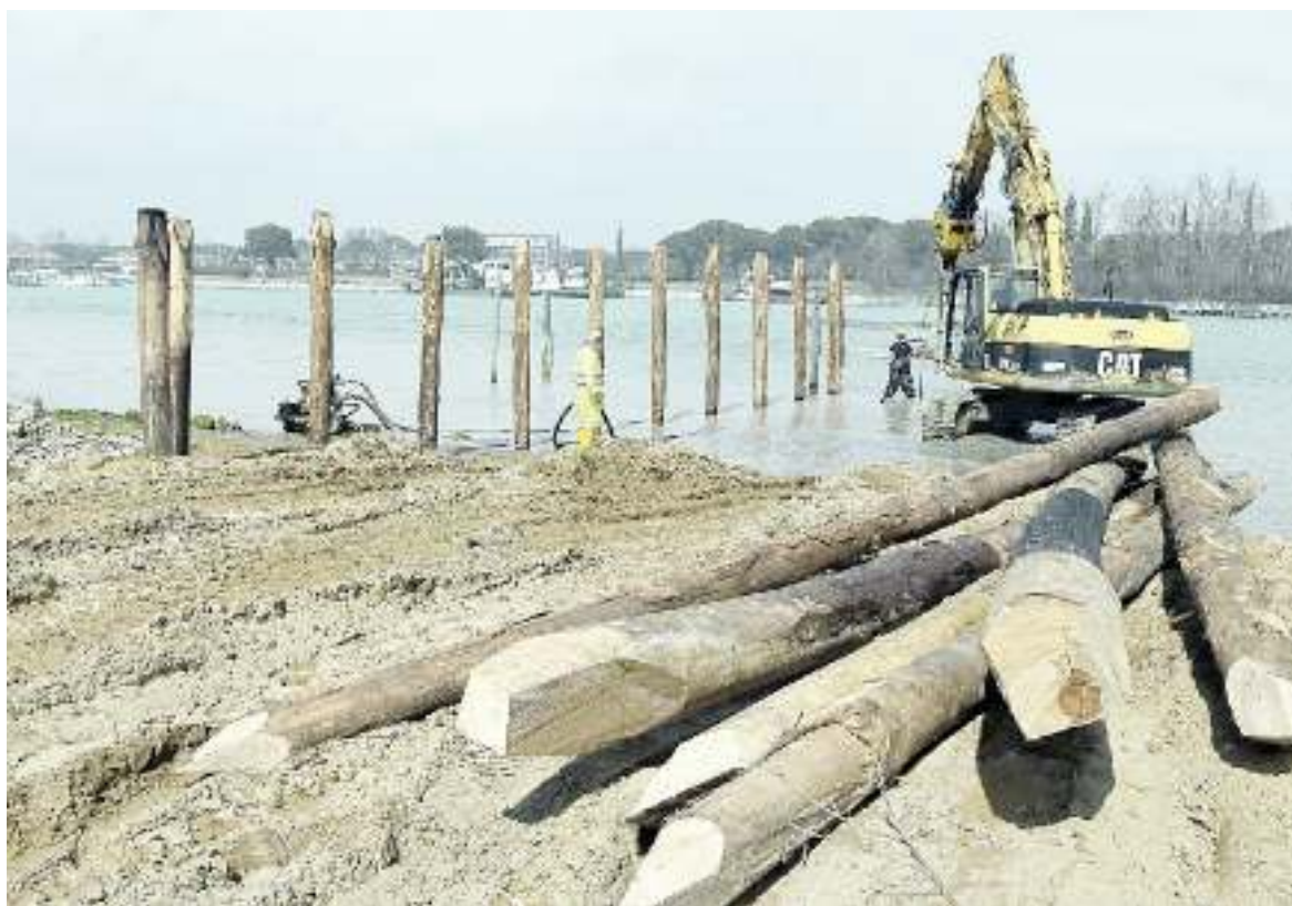
COLLEGAMENTO L'approdo in costruzione a Bibione sulla foce del fiume Tagliamento
