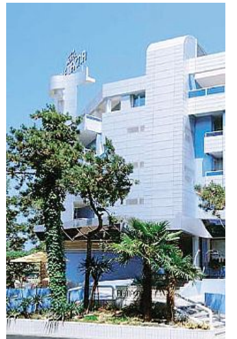
L'Hotel Alemagna (foto dal sito)
