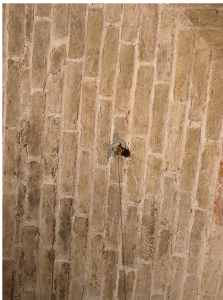
Figura 5.1 Sistema di aggancio all'intradosso della volta della cella campanaria
