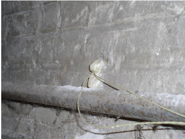
Figura 3.14 Inserimento delle termocoppie nella muratura
