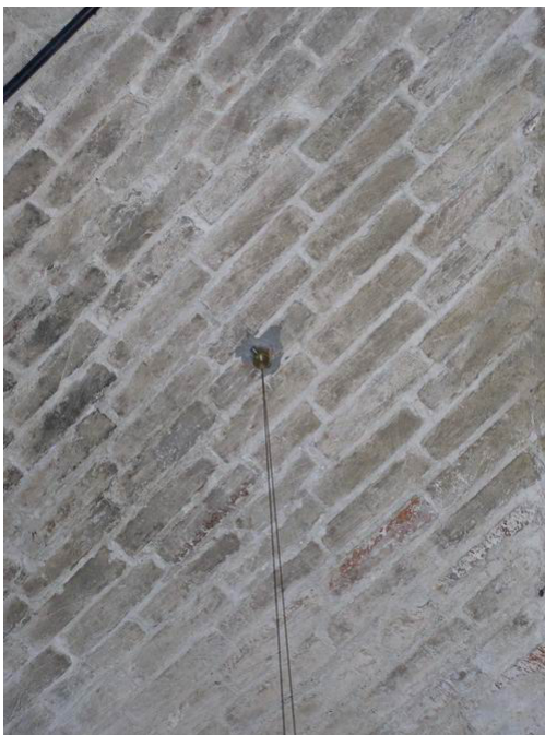
Figura 3.4 Punto di attacco alla volta della cella campanaria
