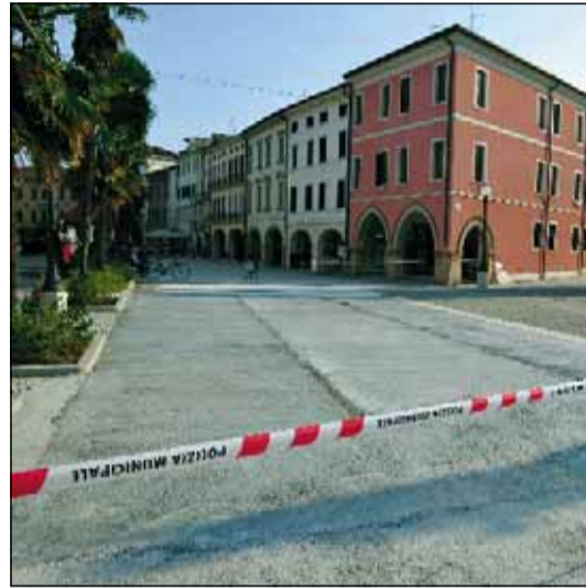
LAVORI Domani apre il cantiere in piazza della Repubblica
